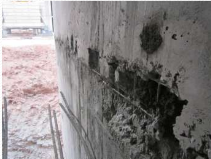
بتن ویبره نشده (اجرا شده قبل از اعطای مسئولیت به شرکت تدبیر ساحل)
