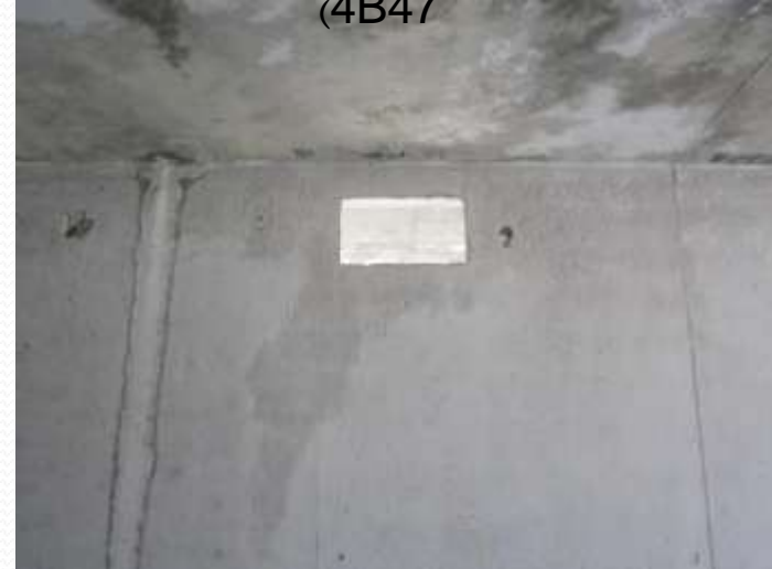
قالب بندی مناسب کانال کولر (بلوک 4B47)
