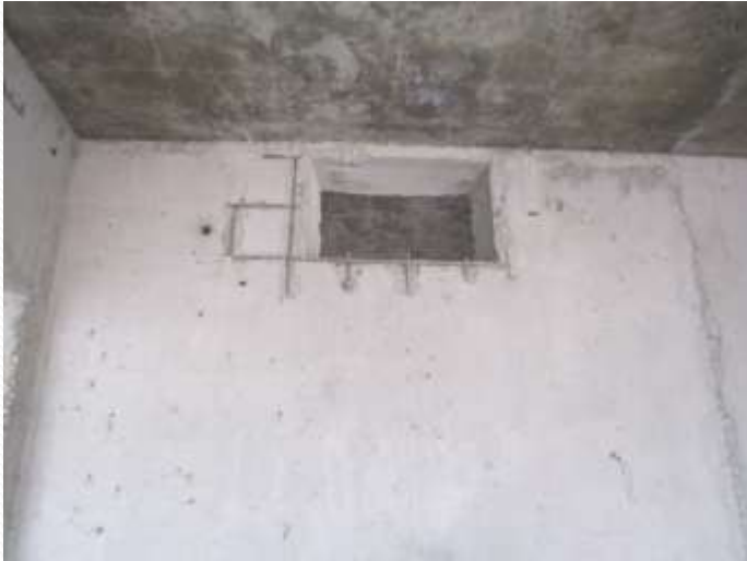
بیرون زدگی آرماتور در اطراف کانل کولر (اجرا شده قبل از اعطای مسئولیت به شرکت تدبیر ساحل)
