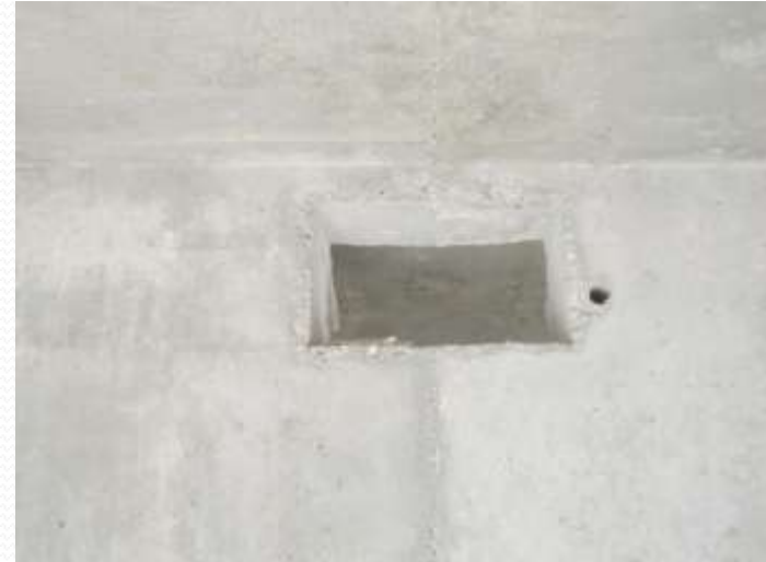
قالب بندی مناسب کانال کولر (بلوک 5B124)
